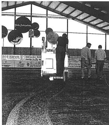
Die Fräse folgt genau dem angezeichneten Kurs.
